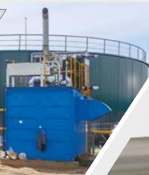
ДОЗАТОР-ЗАГРУЗЧИК ТВЕРДОГО СЫРЬЯ В ФЕРМЕНТАТОР
