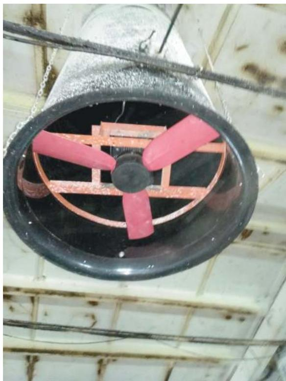
Рисунок 3. – Активная приточно-вытяжная шахта
