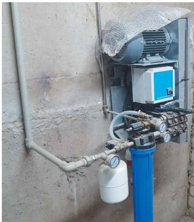
Рисунок 5. – Система охлаждения
