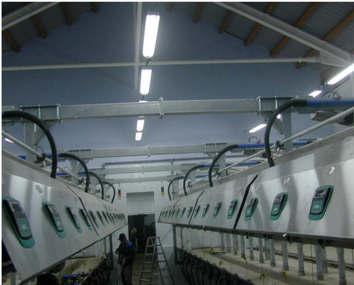
Предназначены для высокопроизводительного доения коров на специальной площадке типа "Параллель".
