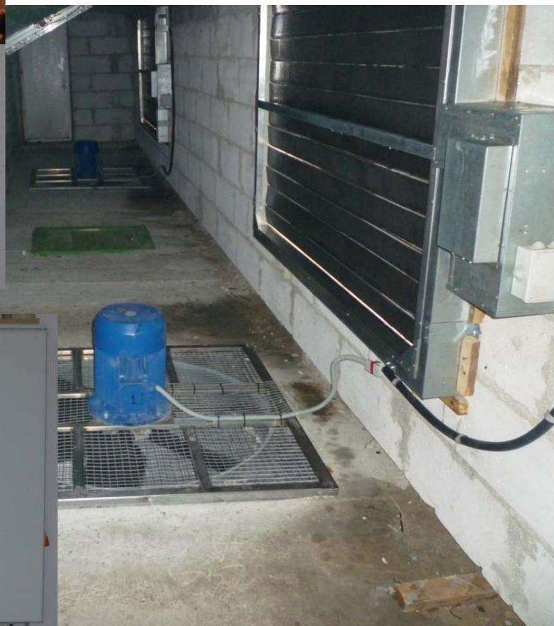
Комплект оборудования модульного типа позволяет реализовывать различные технологические схемы (навалы, контейнеры) активного вентилирования картофеля.
